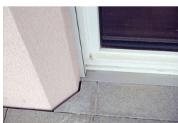
Abb. 3 Fensterleibung mit Abschrägung zur Verminderung der Verschattung
