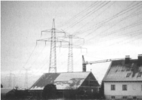
ABB. 11: WOHNGEBÄUDE, DIE IN DER TRASSE DER HOCHSPANNUNGSLEITUNGEN LIEGEN (KÖNIG 2000).
